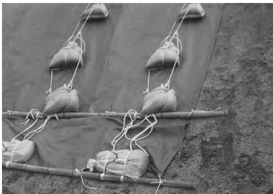
下記写真は骨竹を取り除き浮力を軽減させ シートを法面へ密着させた状態
